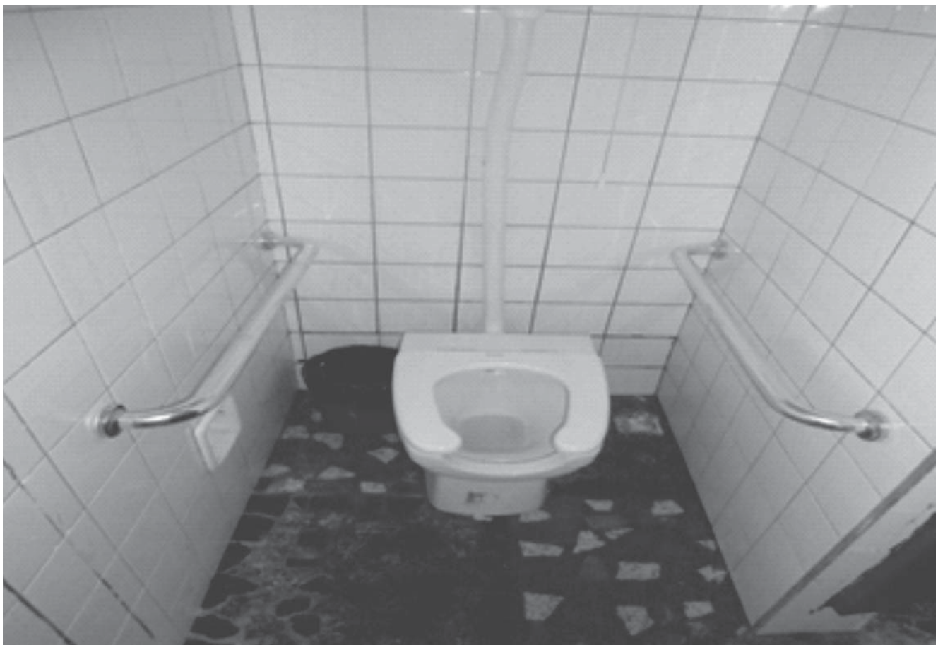
Fig. 3 - Bacia sanitária com abertura frontal e assento e barra de apoio, em 2013. Fonte: Dantas Júnior, 2013.
